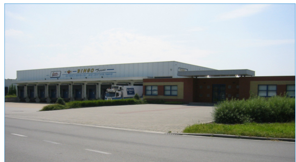
Buitenaanzicht magazijn en kantoren
